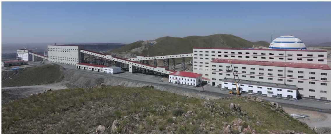
❖ 新落成的30,000吨破碎系统全景。
