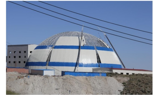
❖ 贮矿：接近完成建设。
