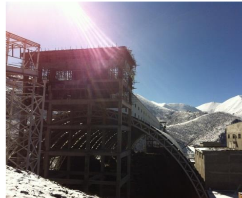
❖ 储矿仓建设即将完成
