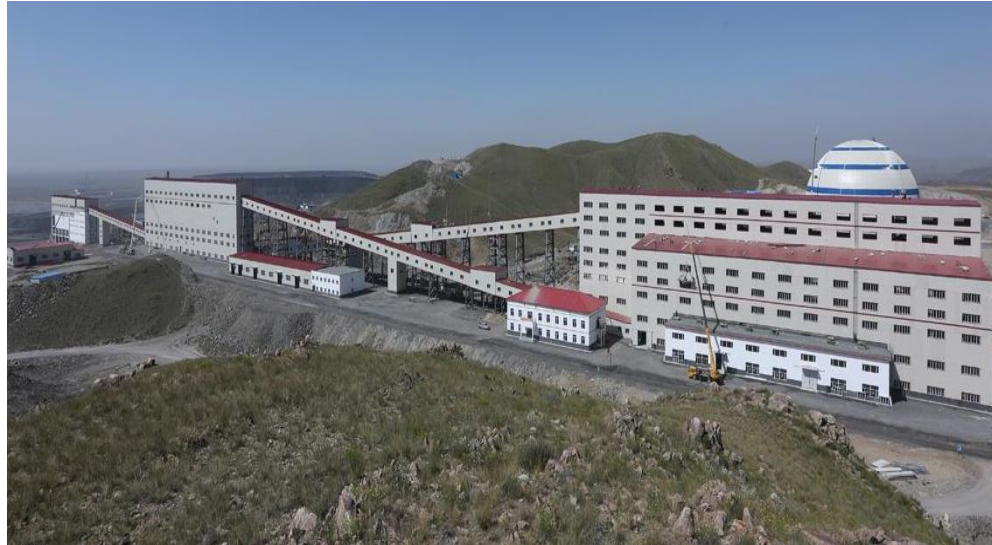
新落成的30,000吨/日破碎系统全景
