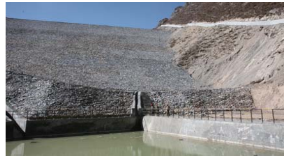
华泰龙公司科技环保的尾矿坝
