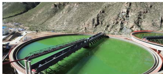
华泰龙公司现代化的浓密池，实现工业废水零排放
