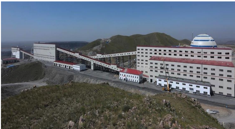
新建成的日处理能力30,000 吨/日的破碎站
