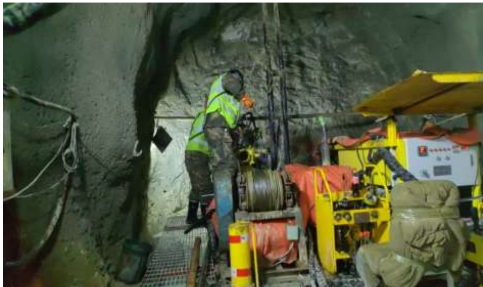
图 10.3 井下钻探施工现场
