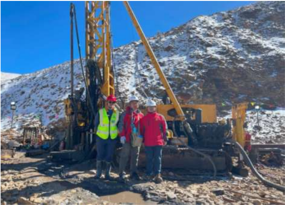
图 10.1 甲玛矿区钻探现场
